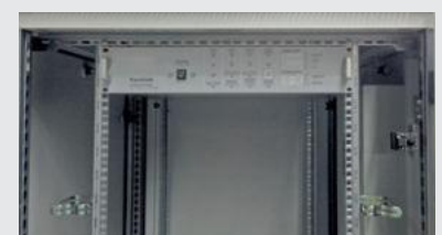
Photo: Installation d'un système d'extinction 19" dans une baie TiRAX « cool & safe »
