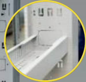
Support de lavage des câbles dans les goulottes de câbles verticales
