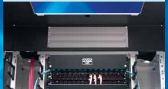
Vue intérieure du corridor froid
